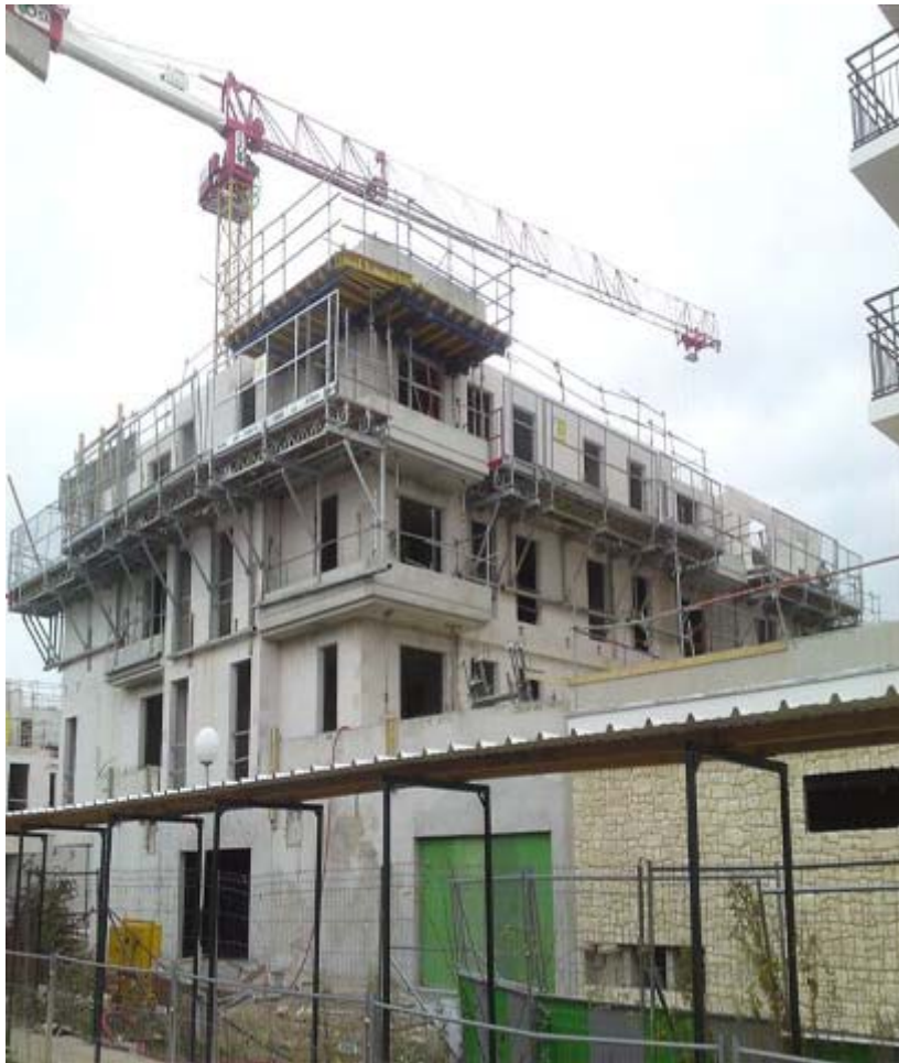
LES MURS EN THERMOPIERRE 22 ET 23 04 10
