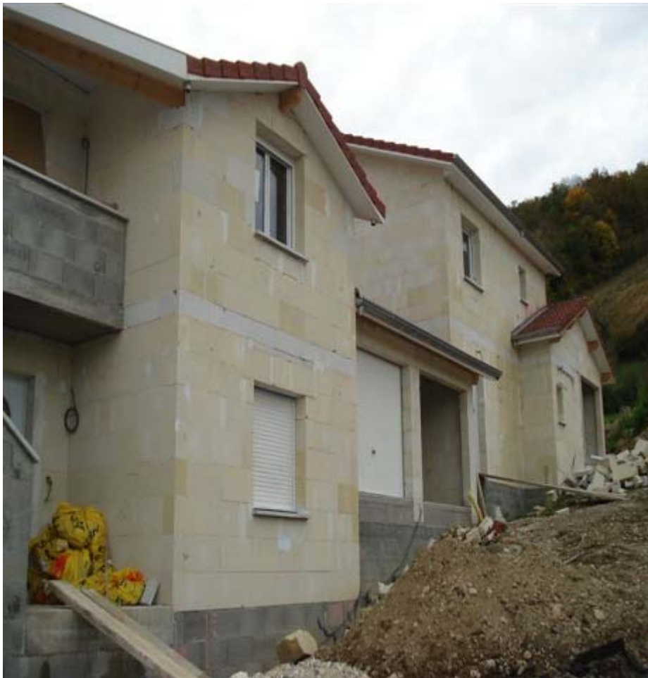
LES MURS EN THERMOPIERRE 22 ET 23 04 10
