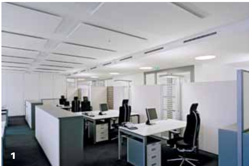
1] Espace ouvert de bureau utilisant la régulation thermique par activation de dalle. Siège de SAP Deutschland AG & Co.KG. Architecte : Emil Schweizer, Häußler GmbH Office Solutions, Acousticien : Manfred Finkenberger (Photo : Stefan Schilling).
